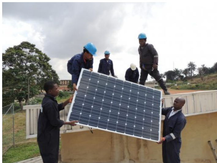
Eine Photovoltaikanlage zur Stromerzeugung wird auf das Dach gehoben.
